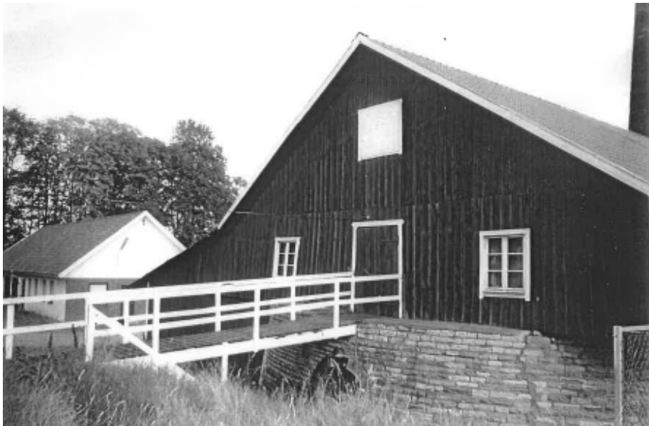
Tegelugnens västra fasad som den såg ut innan ombyggnaden år 2001 (Uppritning och dokumentationsrapport 2000). Panelen var då enklare utförd på gavlarna och hade ett direkt avslut ner mot ugnen.
