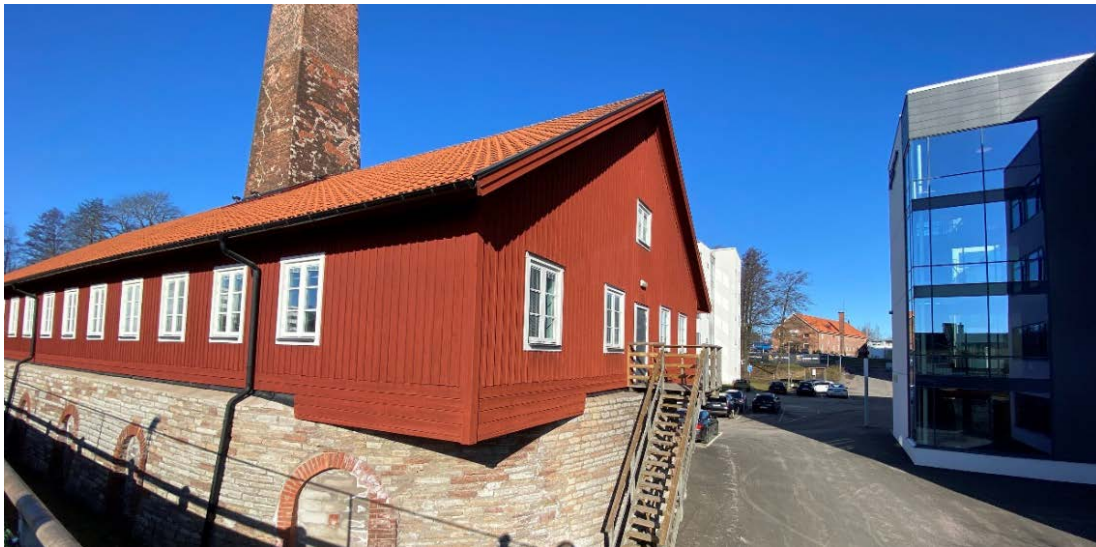
Tegelugnens tak är täckt med tvåkupigt lertegel. Anslutningen mot skorstenen är avtäcktt med svartmålad plåt.
