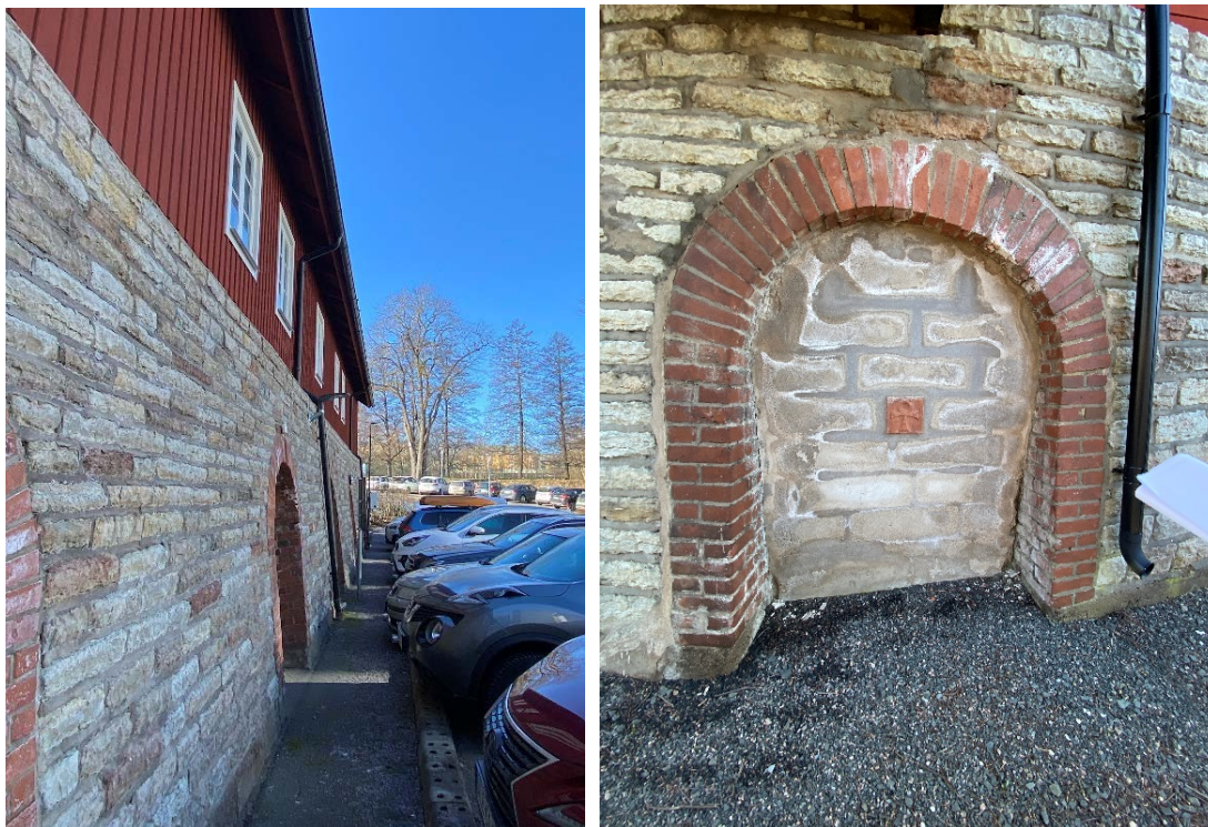
Byggnadens nedre del, ringugnen, är täckt med kalksten. Ugnsöppningarna som återfinns runt hela ugnskonstruktionen är utförda med tegelförsedda valv.
