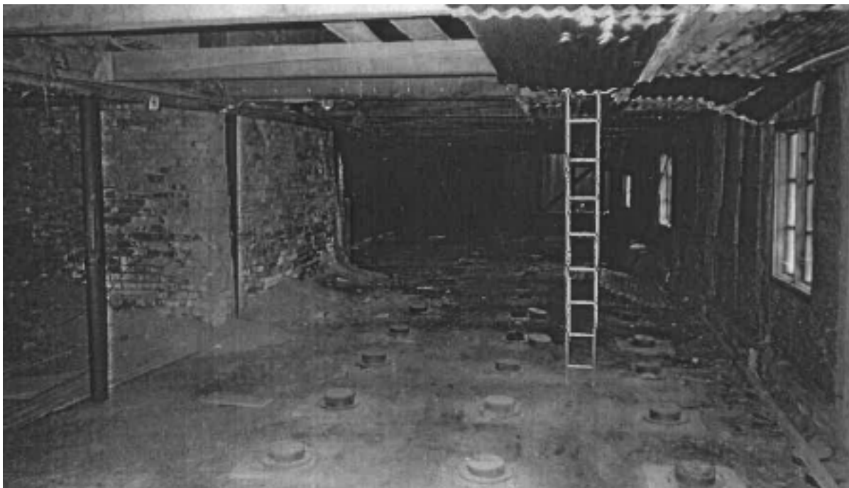
Bild från den ursprungliga interiören. I golvet fanns öppningar där man kunde lägga ner ny ved till ugnen som ligger under golvet. Golvet var täckt med ett 50 cm tjockt lager sand.
